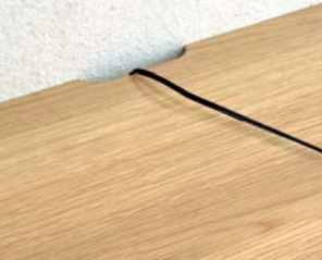
配線用欠込みを設けた天板
